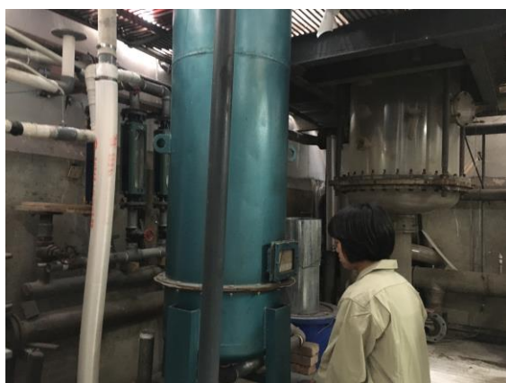
(a) 自来水厂净水塔
