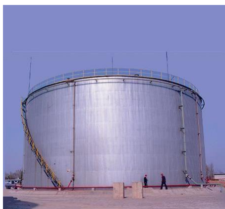
(a) 大型油罐
