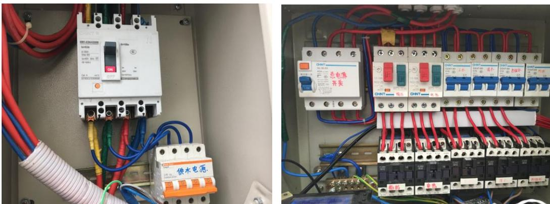
图 6-7 目前的交流电源适配中最常见的安全保护措施
